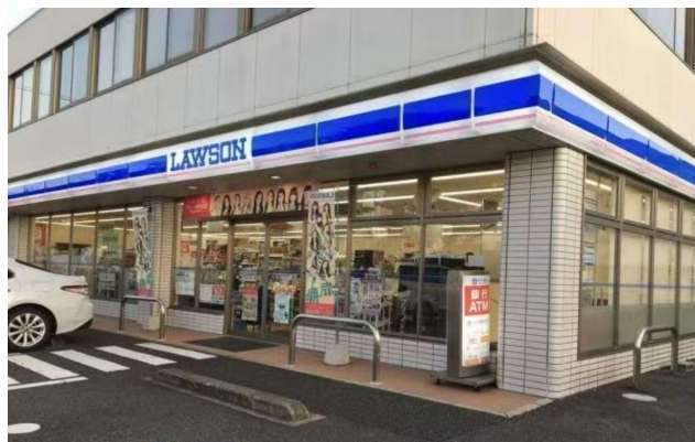
ローソン大村古賀島町店 様 (長崎県大村市) ・コンビニエンスストア ・設置枚数4枚
